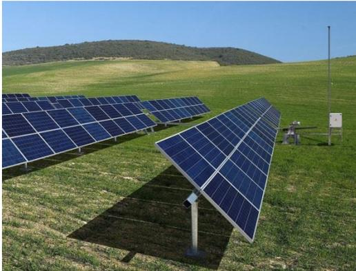
Seguidor horizontal eje Norte-Sur
