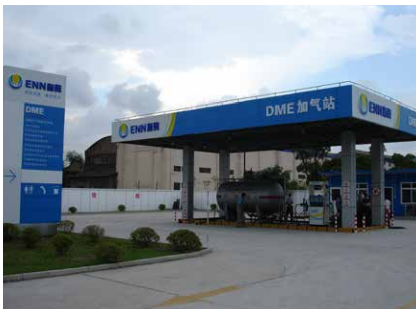
图 17. 2008 年中国上海的二甲醚加注站和加注泵
