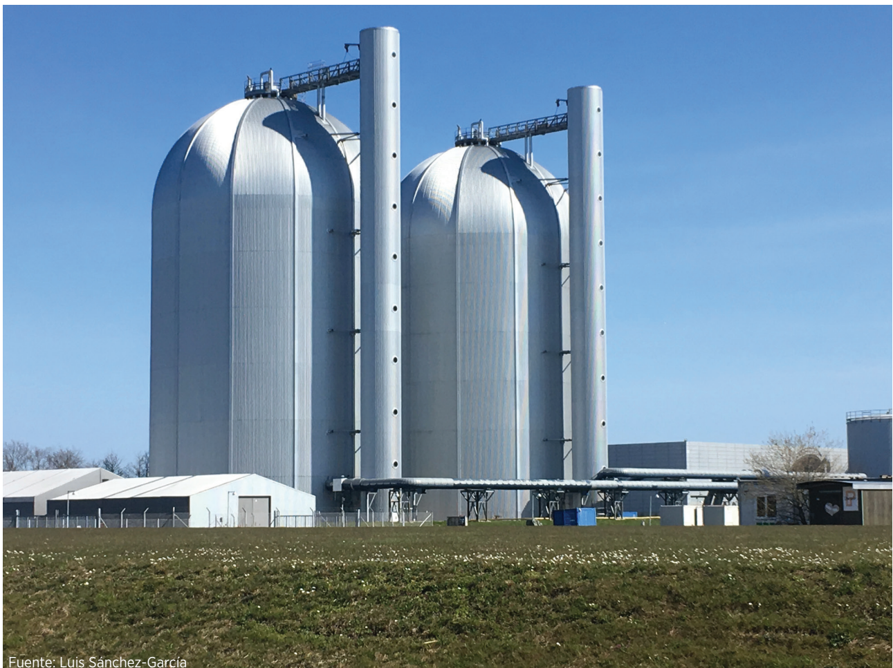
Fotografía 4 Almacenamiento de calor (44 000 m 3 ) en Avedøre Kraftværket, en Copenhague (Dinamarca)
