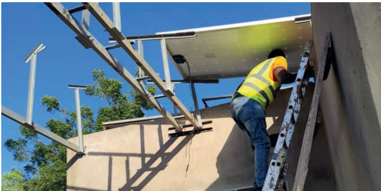
Installation de panneaux solaires à la Clinique Wolobougou, près de Bobo-Dioulasso, au Burkina Faso.
